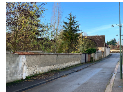
Mur de clôture traditionnel le long de la rue des Bidaux
