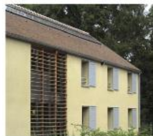
Un ensemble de capteurs thermiques souligne le faitage de la toiture. Centre médicalisé à Bullion (Yvelines). Cabinet Méandre, architectes © PNR Haute Vallée de Chevreuse
