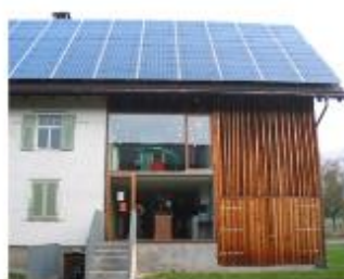
Un ensemble de capteurs recouvre toute la surface du toit, comme une nouvelle couverture. Crèche à Zwischenwasser (Vorarlberg, Autriche) © CAUE 78
