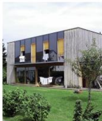
Les capteurs posés verticalement participent pleinement de la composition de la façade. Maison individuelle à Wofurt (Vorarlberg, Autriche) © CAUE 78
